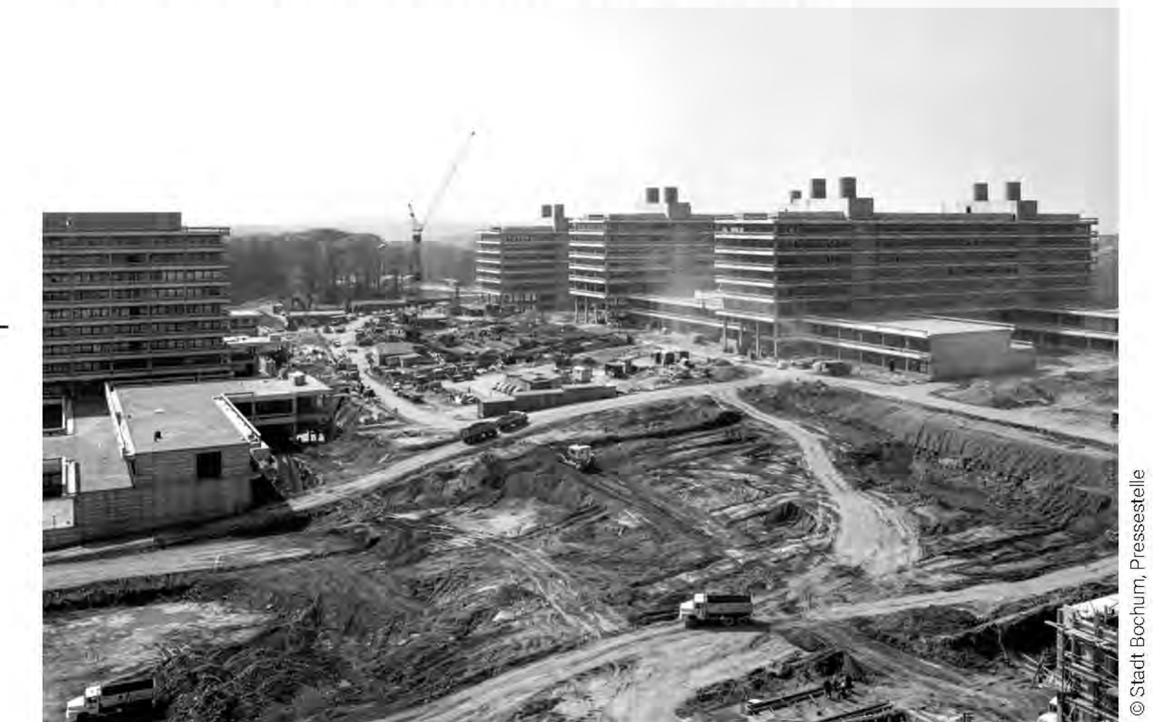
1970 - Bau der Ruhr-Universität
